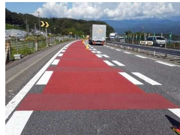
写真 カラー薄層舗装の施工 中央道上り 松川～飯田(2024年9月対策完了)
