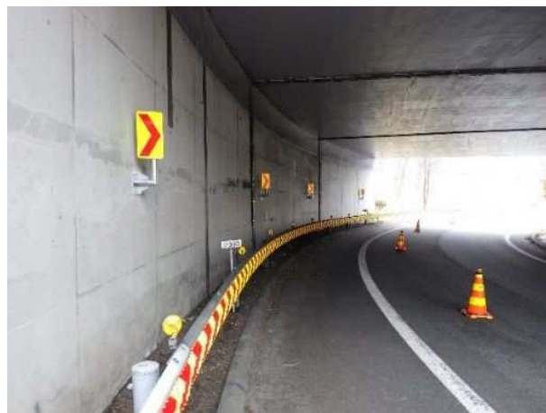
写真 視線誘導標の設置 中央道 岡谷IC(2024年3月対策完了)
