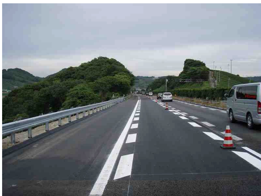
<本線舗装工事完了(上り線)>
