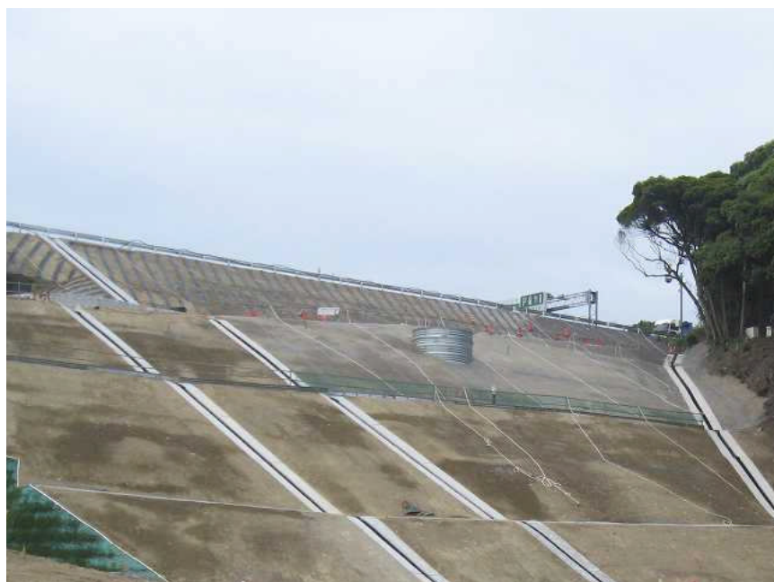
<盛土工完了(上り線)>
