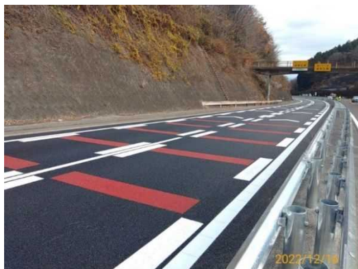
写真1 カラー薄層舗装(中央道 多治見～小牧東) (2022年12月対策完了)
