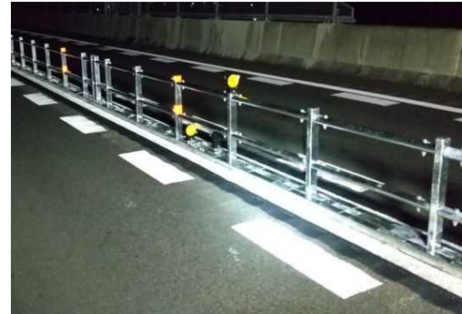
写真 4 センターパイプ(長大橋)
