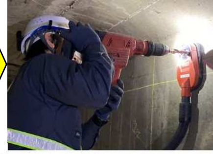
② 調査孔削孔・シース開削
