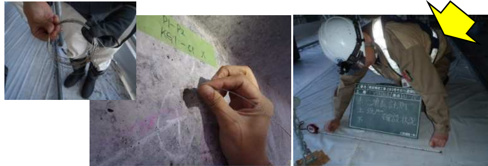
④ 空洞量調査(検測尺法※1の例)
