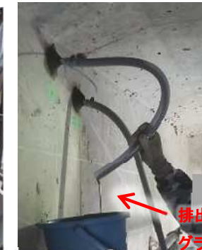
⑤-2 PCグラウト再注入 (再注入作業: 圧入方式の例※2)
