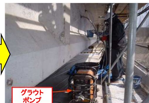
⑤-2 PCグラウト再注入 (再注入作業: 圧入方式の例※2)
