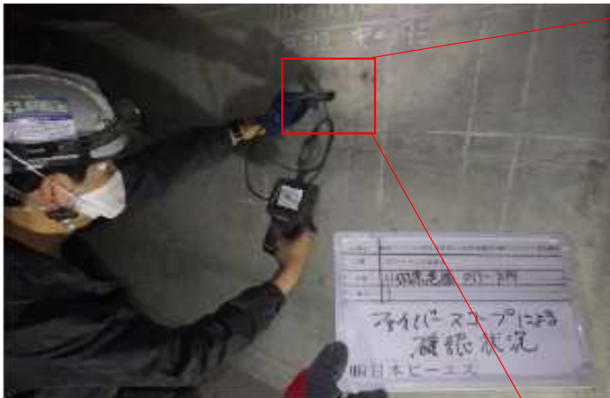
PCグラウト充填調査状況(削孔調査)
