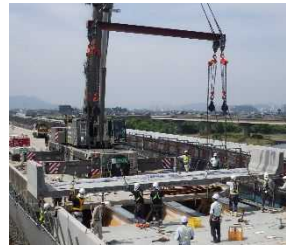
【橋梁床版取替】
