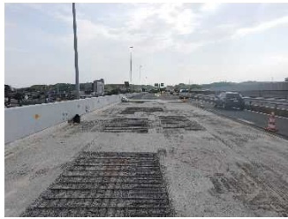
【橋梁床版補修】
