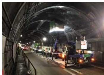
【トンネル覆工補強】
