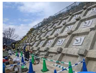
【グラウンドアンカー補強】
