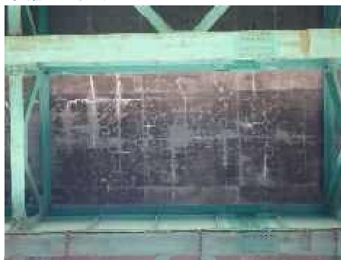
写真-5 コンクリートのひび割れ、遊離石灰の漏出
