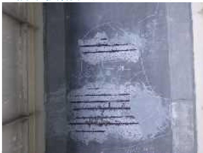
写真-4 コンクリートのはがれ落ち、浮き、鉄筋の露出
