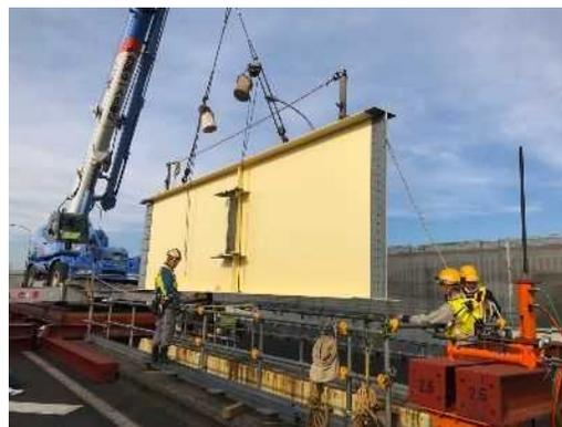
車線確保の場合は、中央分離帯を車線として利用するため、床版取替前に中央分離帯へ橋桁を新規に増設します。
