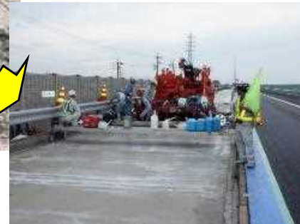
床版増厚の施工完了状況
