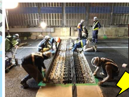
伸縮装置の取り替状況
