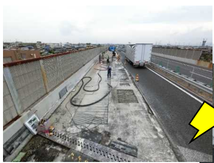
床版の損傷状況
