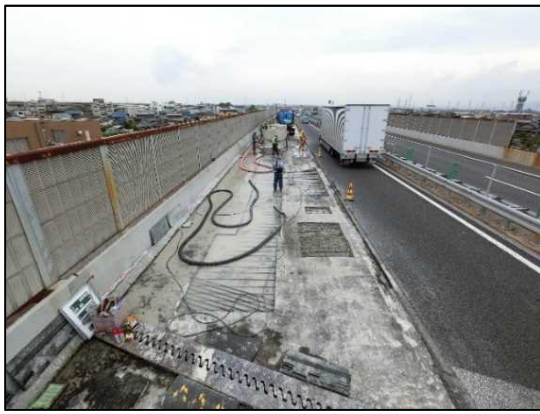
I. 舗装・床版の補修状況
