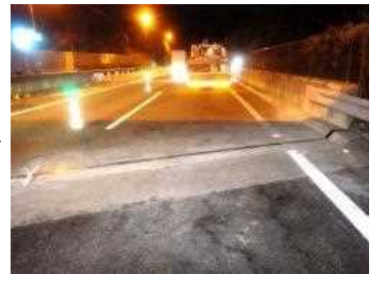
伸縮装置取替完了イメージ
