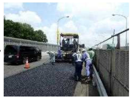
舗装補修工事の状況
