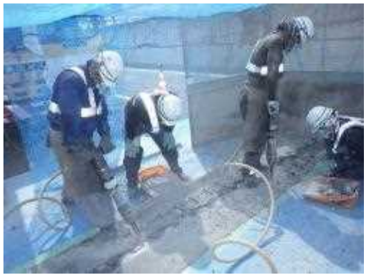
伸縮装置の取り替え工事状況
