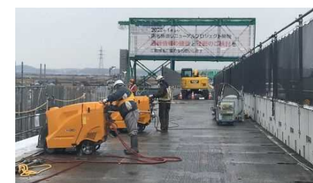
↑ 老朽化した床版の撤去の準備として、カッターで床版を切断する作業をおこなっています。
