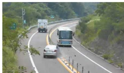
ワイヤロープの設置で反対車線に飛び出さずに停止
