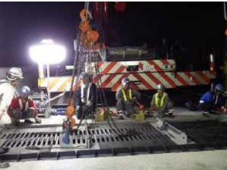
III. 新しい伸縮装置の設置
