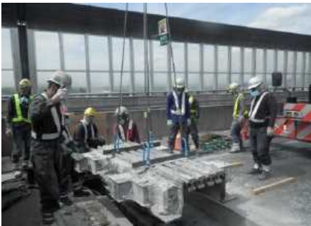
III. 新しい伸縮装置の設置
