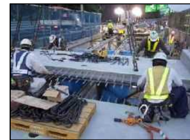
新しい床版の設置
