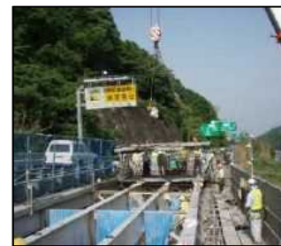
老朽化した床版の撤去
