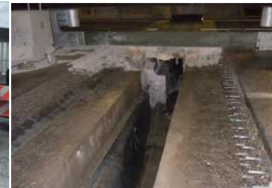
II. 伸縮装置の撤去後の状況
