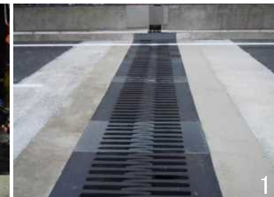
IV. 工事完了
