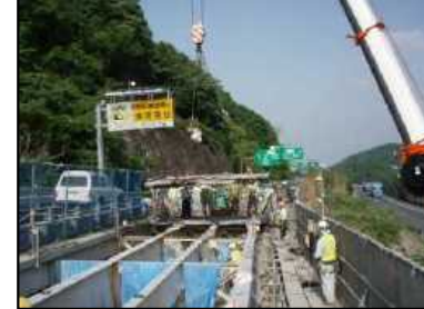
老朽化した床版の撤去
