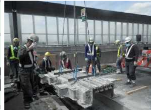
I. 既存の伸縮装置を撤去
