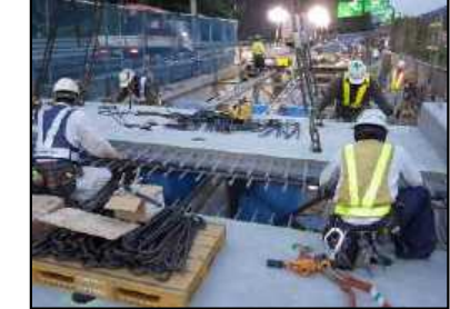
新しい床版の設置
