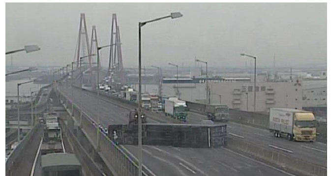
伊勢湾岸道 事故による通行止め時の状況
