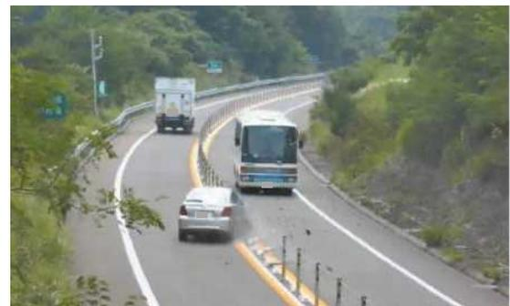
ワイヤロープの設置で反対車線に逸脱せずに停止
