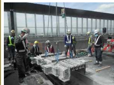
橋梁の伸縮装置の取替状況
