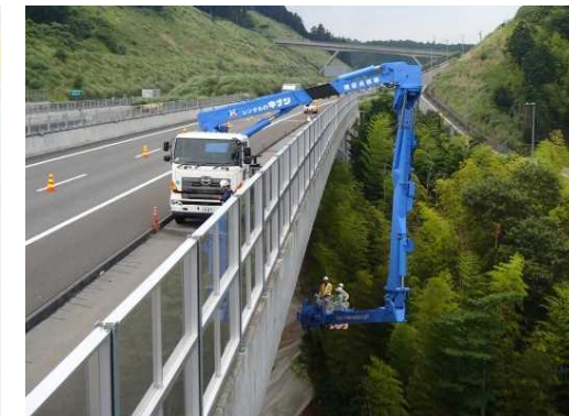
橋梁の点検状況
