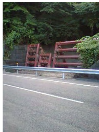
＜応急復旧完了状況＞
