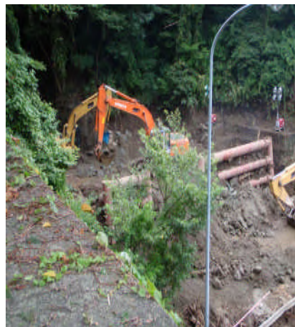
＜応急復旧作業状況＞
