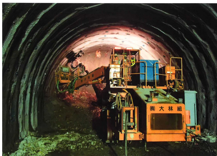
写真１ トンネル坑内（掘削状況）
