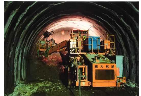
トンネル坑内（掘削状況）
