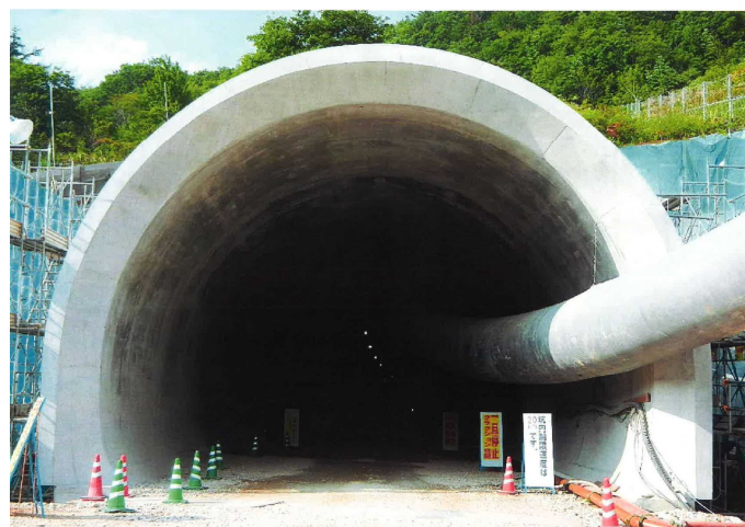
写真２ トンネル坑口（北側）
