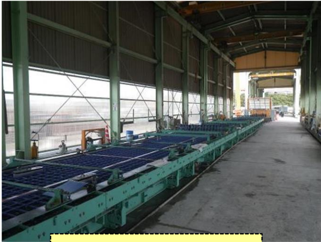
床版の製作状況<用宗高架橋>
