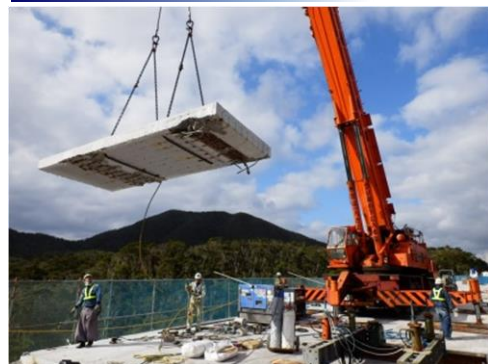
老朽化した床版の撤去
