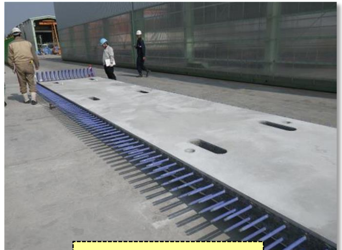
用宗高架橋で使用する床版
