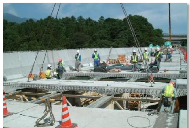
参考：床版取替状況（プレキャストPC床版の設置） <中央自動車道 伊那IC～駒ヶ根IC間 小沢川橋>
