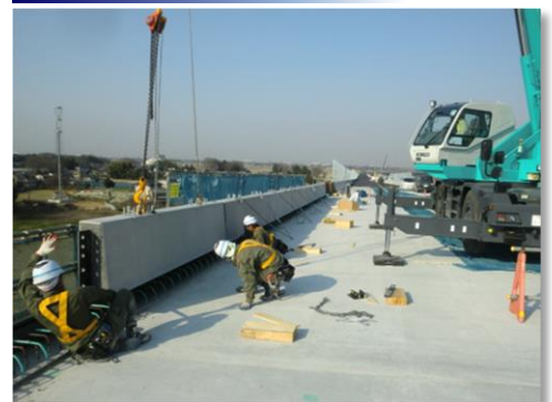
新しい壁高欄の設置
