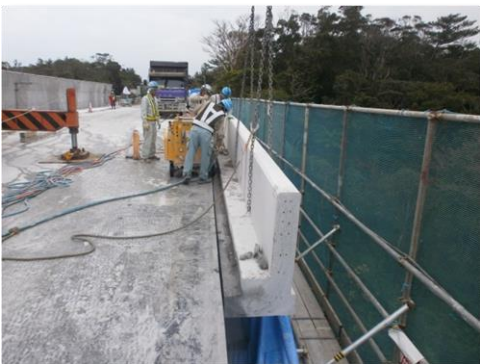
壁高欄の撤去
