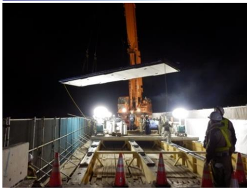
新しい床版の設置
