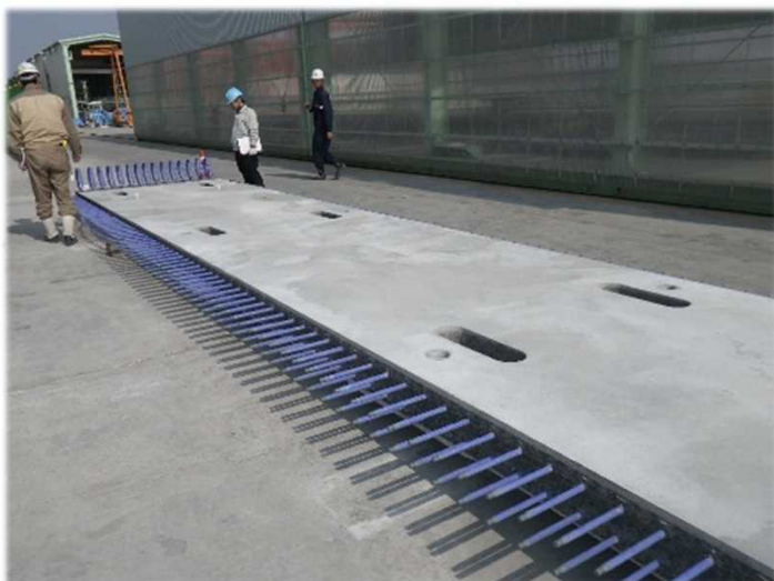
■ 用宗高架橋で実際に使用するプレキャストPC床版・製品検査状況
