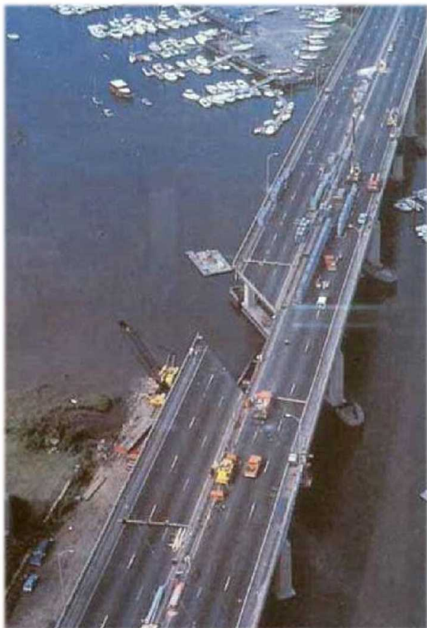
【マイアナス橋の崩落の状況】
