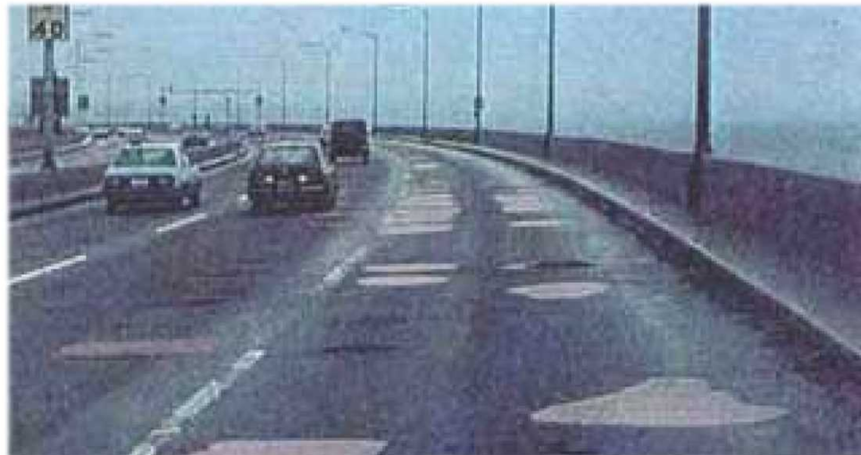
【有料橋の床版補修】
