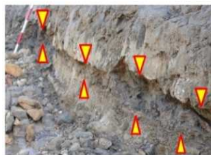
※近傍ののり面状況
