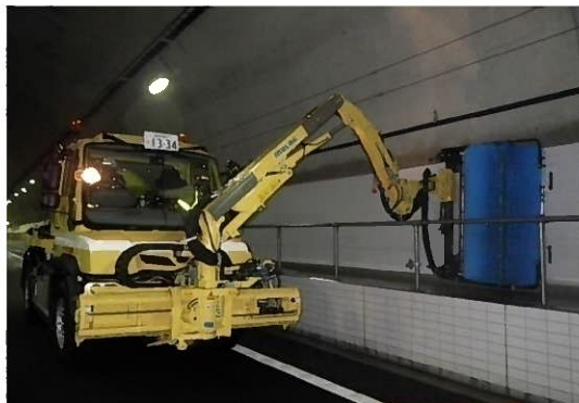
《トンネル側壁清掃》
