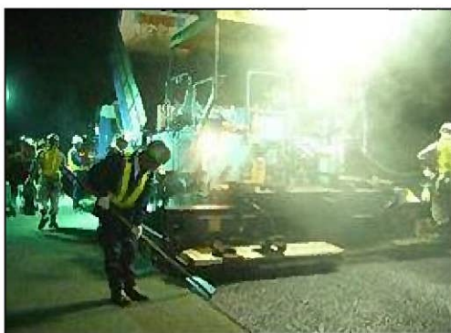
《舗装補修工事》
