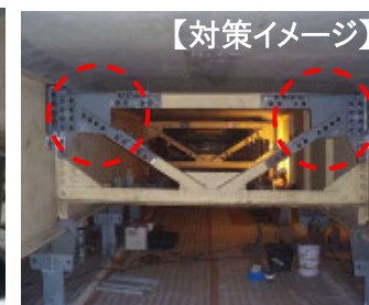
増設した対傾構 補強部材の取り付け
