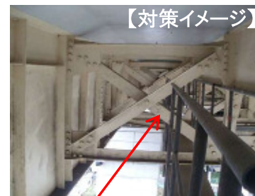
増設した対傾構 補強部材の取り付け
