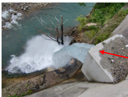
庄川への湧き水の放水状況
