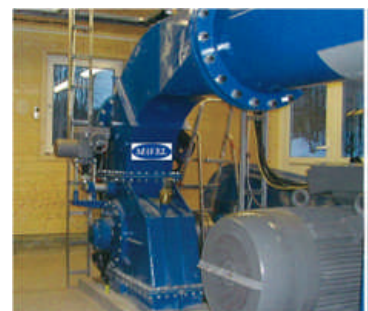
水力発電設備(イメージ)
