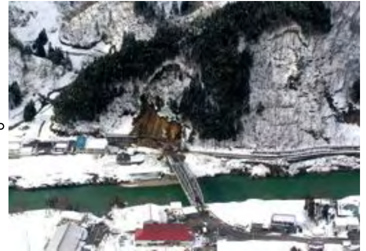
国道156号災害現場
