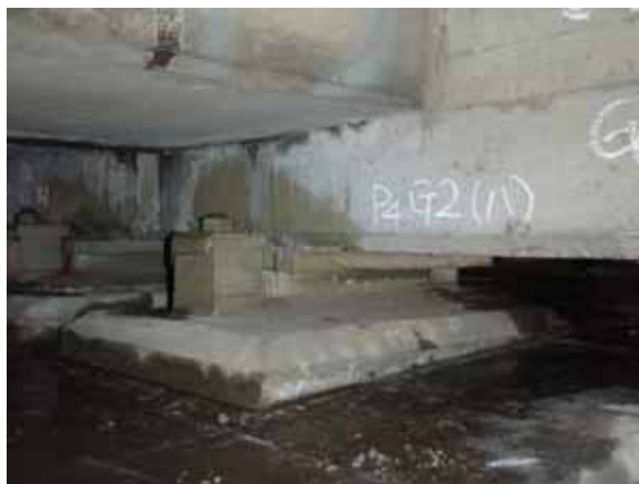
施工前の支承部の状況
