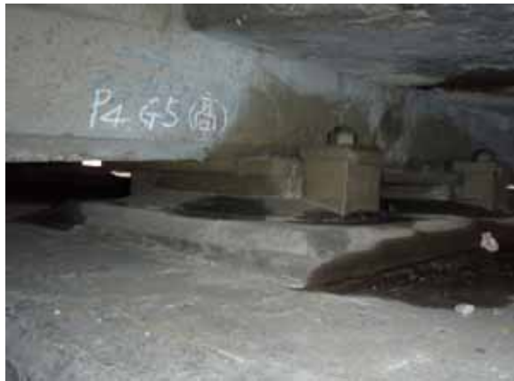
施工前の支承部の状況
