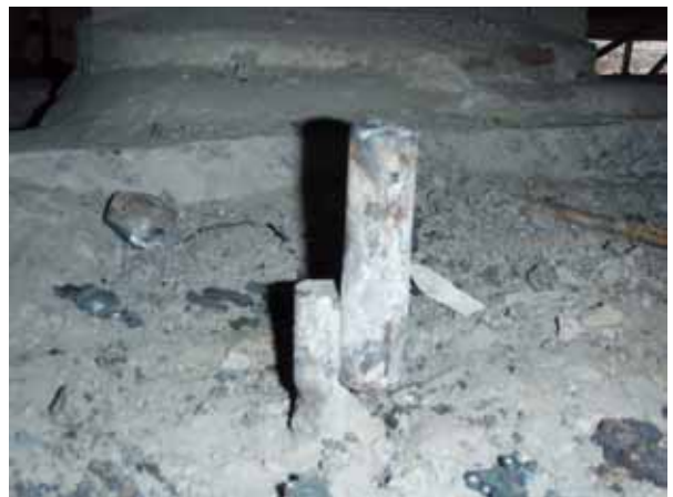
支承撤去後 アンカーボルト部の溶接を確認
