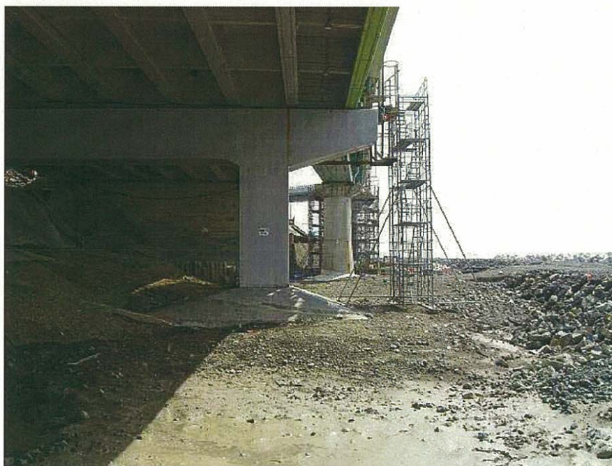
暫定4車線供用前状況写真(金波橋の下から大磯方面) 平成20年4月15日撮影
