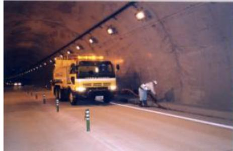
トンネル壁などのマイマイガの卵駆除、破損した車線分離標を取り替えます。
