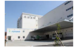
写真出典：鴻池運輸(株)関東支店 厚木流通センター営業所
