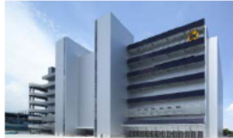
写真出典：ヤマト運輸(株) 厚木主管支店
