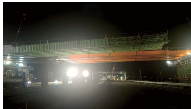
夜間通行止め架設のイメージ(写真は名神高速道路養老JCTでの様子です)
