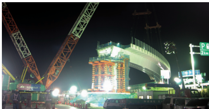
夜間通行止め架設のイメージ(写真は名神高速道路養老JCTの様子です)
