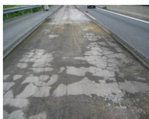
舗装の損傷事例 (道路基層部のひび割れ)
