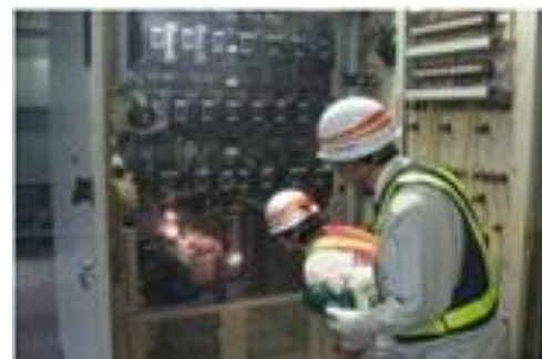
整備故障ゼロ化推進に向けた部品の更新状況
