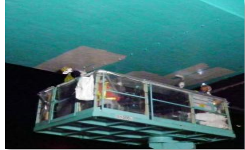
断面修復工の施工例
