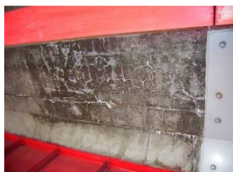
橋梁の損傷事例 (床版下面の亀甲ひび割れ)
