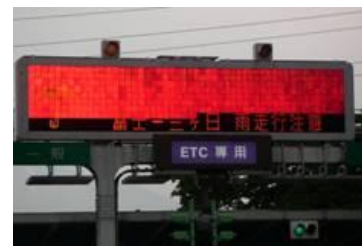
施設設備の損傷事例 (情報板の表示部劣化)
