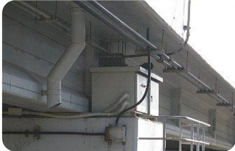
電気防食工の施工例
