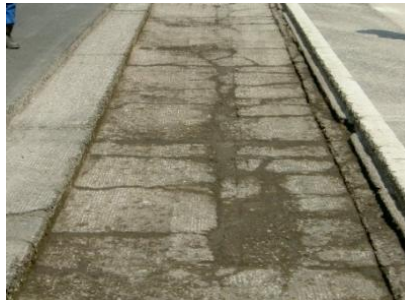
深層部（路盤）のひび割れ状況
