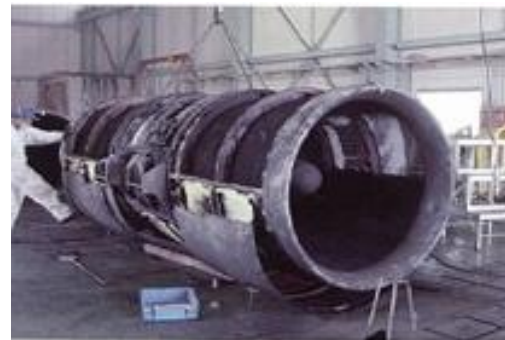
計画的な補修整備実施状況（ジェットファンの分解整備）
