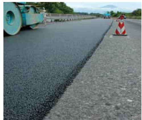
舗装補修工事状況
