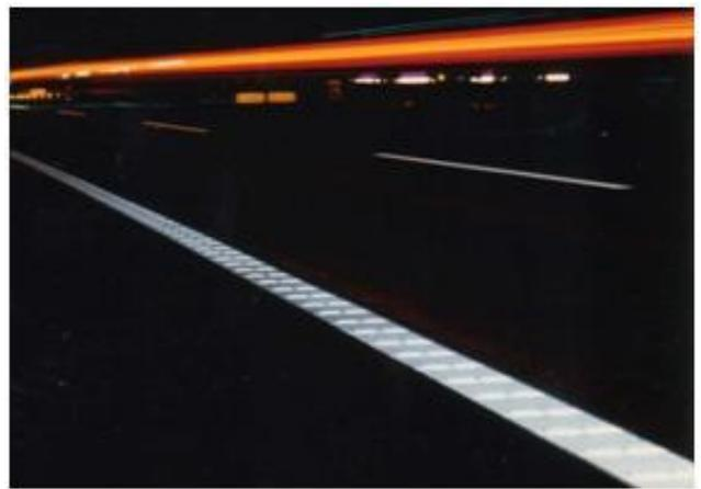
※ランブルストリップスとは、舗装路面に凹型の溝を連続して配置する工法で、振動や音により警告を行う交通安全対策である。
