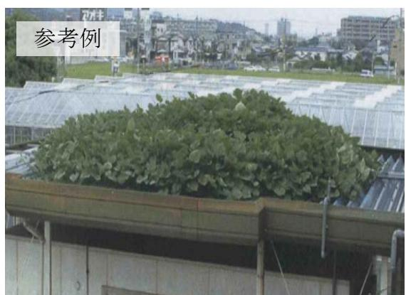
蒸発作用が強く緑量の多い植物にて緑化することにより、屋内の温度上昇を抑える（断熱効果）とともに蒸散作用により周辺温度上昇の緩和に役立ちます。
