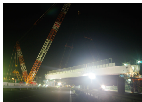
夜間通行止め架設のイメージ (写真は名神高速道路 養老JCTでの様子です)
