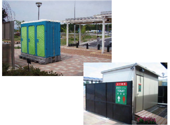
仮設トイレの設置
