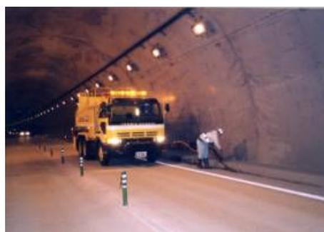
消えかかっている路面標示の引き直し、破損した車線分離標を取り替えます。
