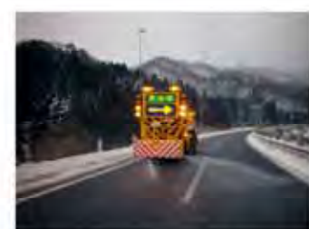
■ 凍結防止剤散布作業
