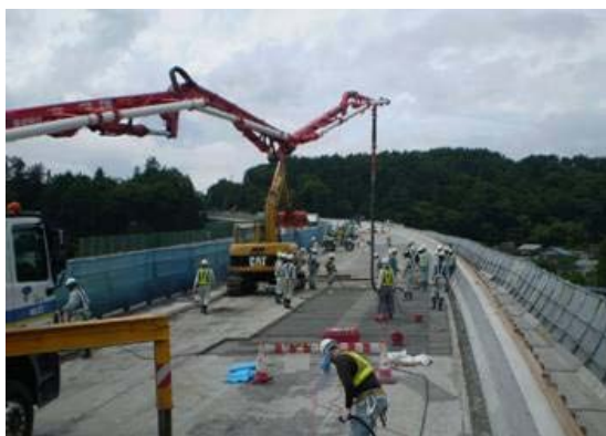
床版補修状況
