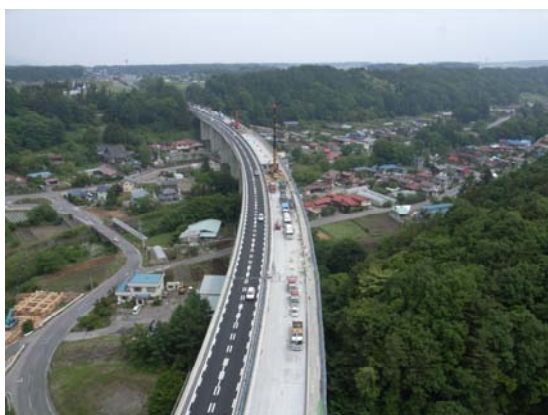
工事全体イメージ
