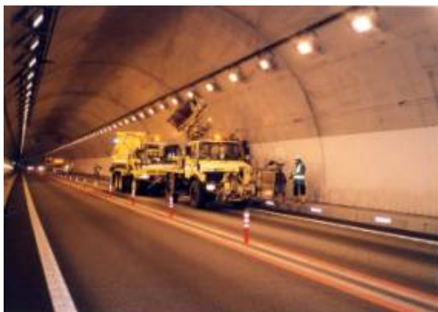
トンネル壁面清掃
