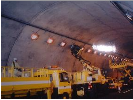
トンネル照明設備清掃・点検
