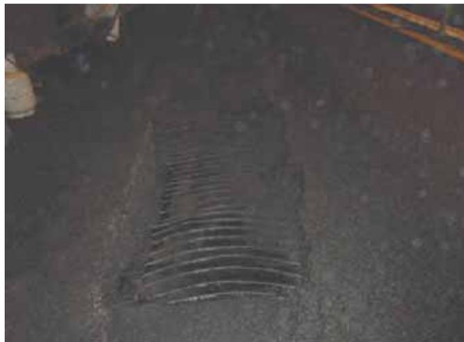
ロードヒーティングの露出・損傷
