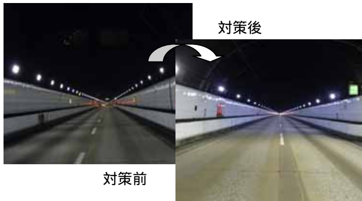
トンネル照明の照度アップによる暗がりや圧迫感緩和
