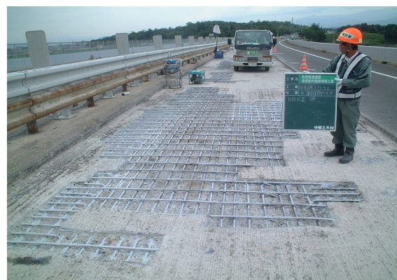
凍結防止剤によるRC床版の塩害被害
