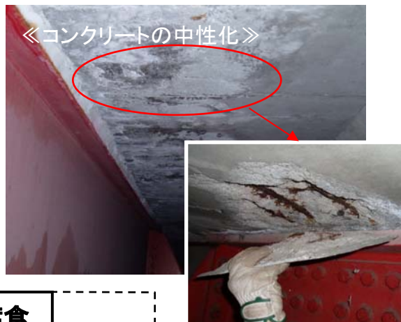
《鋼材の腐食》
