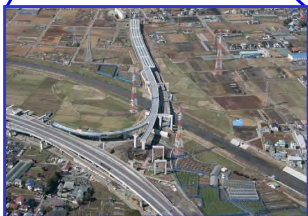
西久保JCT（仮称）付近
