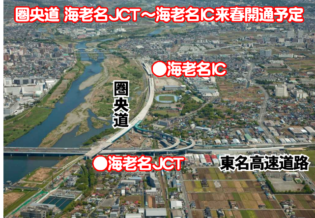
▲圏央道 海老名JCT付近
