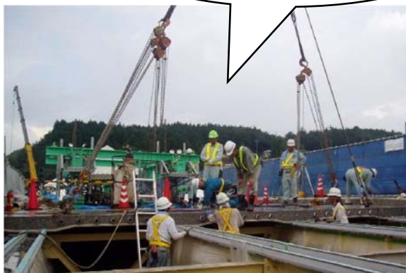
プレキャスト床版設置状況（他の類似工事施工模様）
