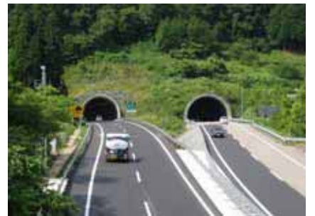
4車線化後の状況
