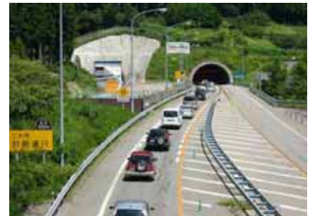
4車線化前の状況
