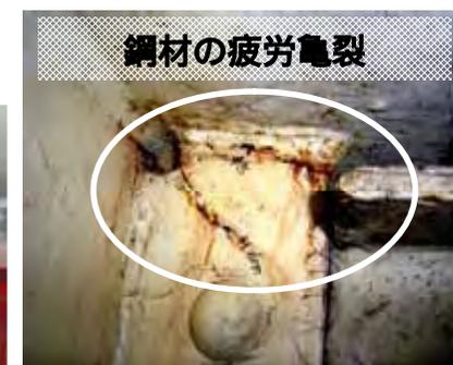
伸縮装置、鋼製支承 消耗品として取扱い定期的な交換サイクルに基づく補修すべき部材
